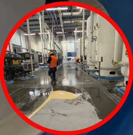
Colocacion de varrera de vapor.
